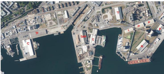
PV sur les toits des bâtiments portuaires
